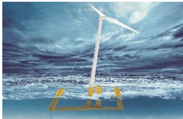
一点係留2枚翼ダウンウィンド浮体式洋上風車
