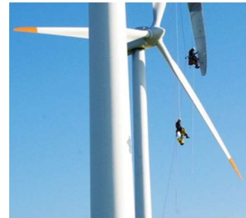
メンテナンス作業風景
